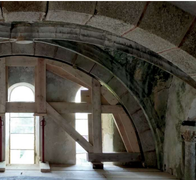
▲ Reprise et consolidation des voûtes. PHOTO PIERRE CONDRE
